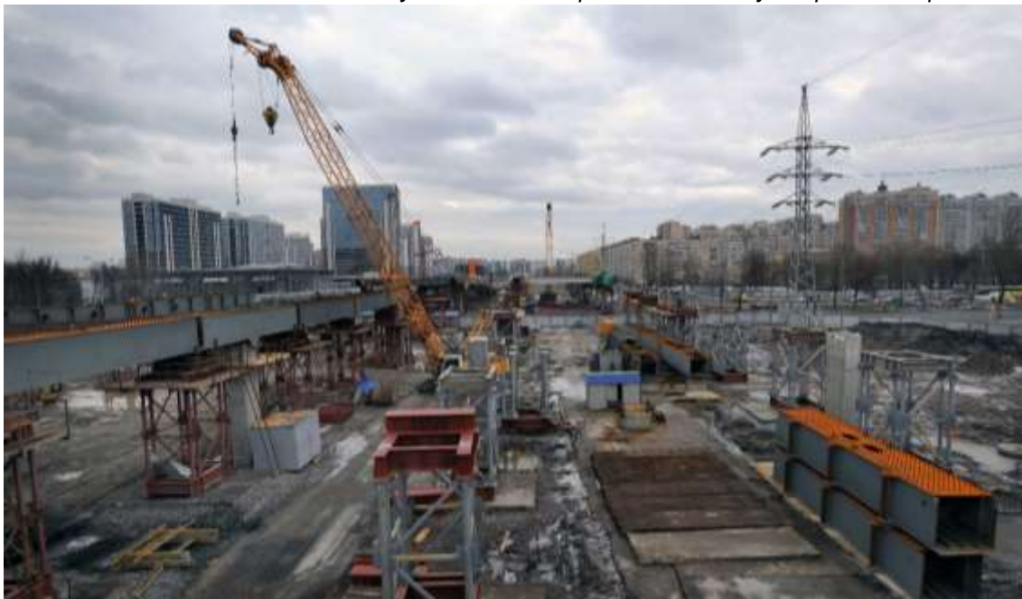
Рисунок 14. Ход строительства путепроводной развязки
