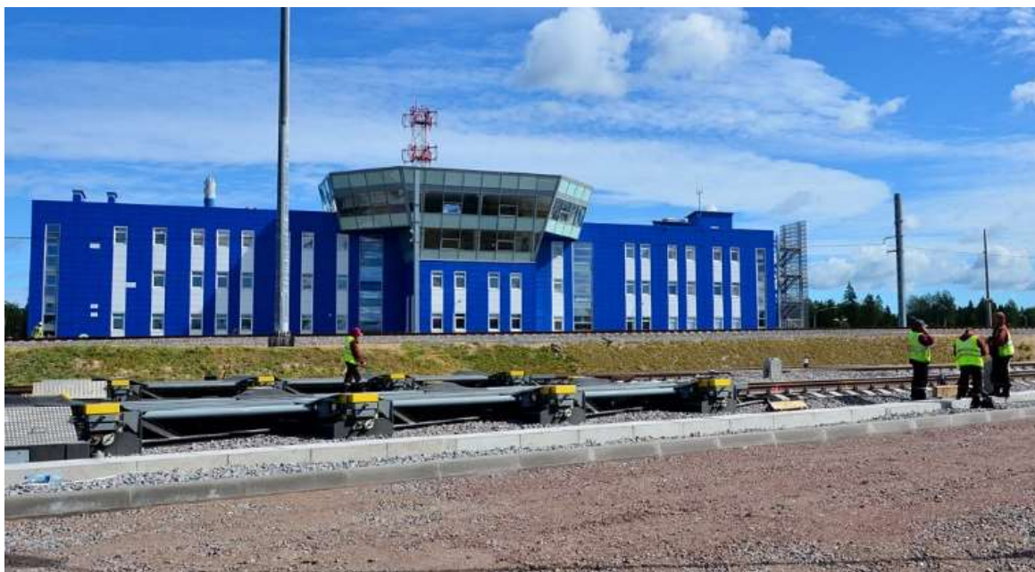
Рисунок 5. Пост горочной централизации с АБК на станции Лужская-Сортировочная
