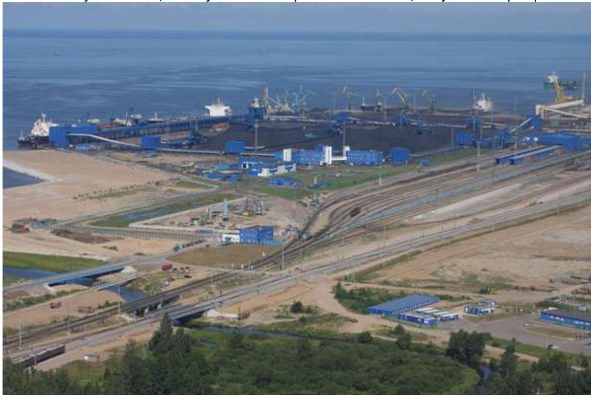
Рисунок 4. Общий вид угольного терминала на станции Лужская-Сортировочная
