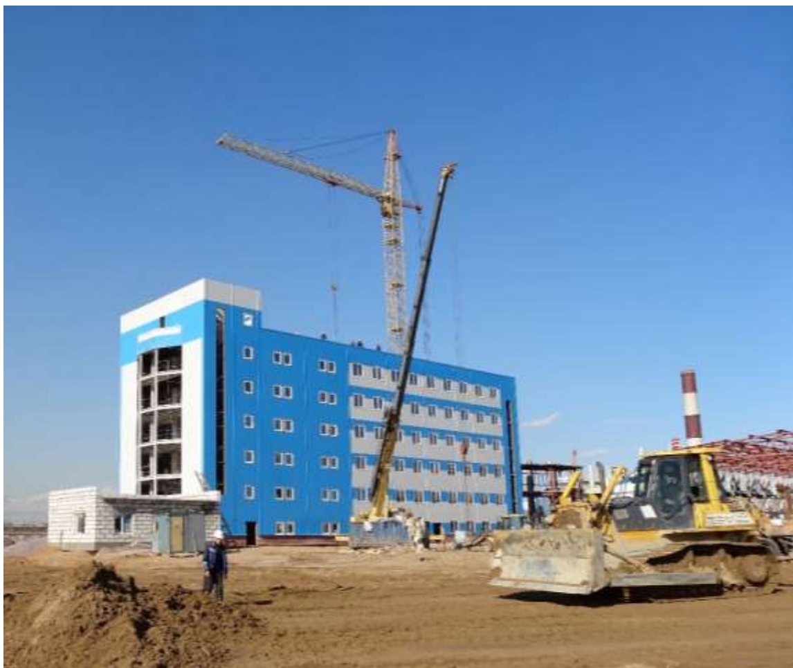
Рисунок 12. Ход строительства электродепо «Южное», апрель 2016 г.
